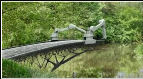
Les robots devront fabriquer ou plutôt imprimer sur place un pont complet surplombant un canal.
