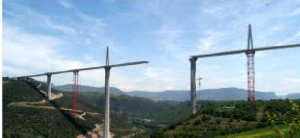
Le viaduc de Millau avant la jonction
